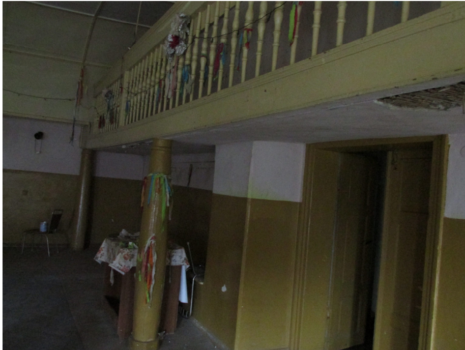
Balkon im Saal des Gerichtskretscham (1. Etage)
