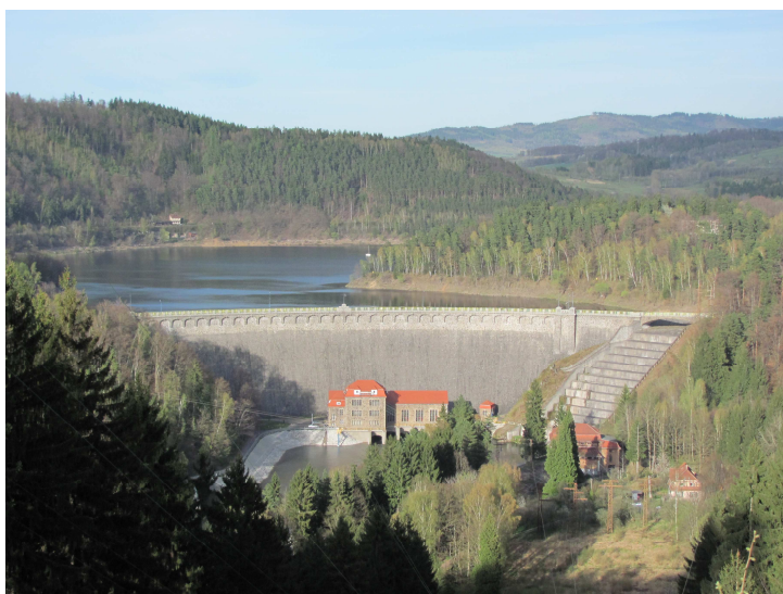
Die Bobertalsperre bei Mauer im April 2012
