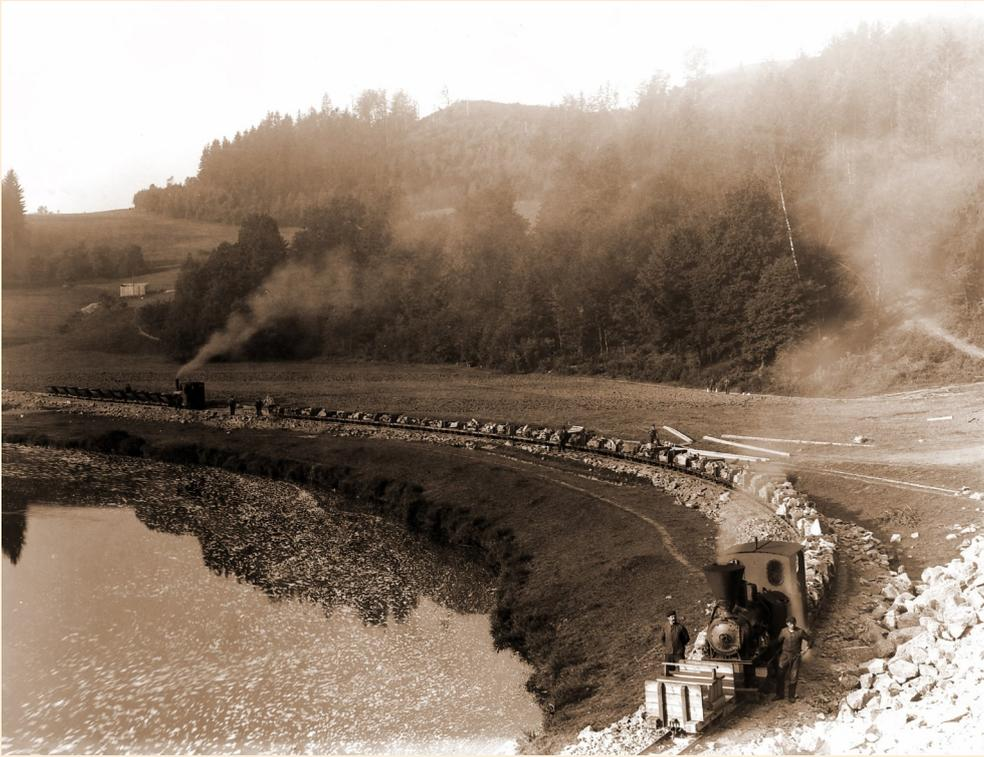
Abbildung der Feldbahn beim Bau der Bobertalsperre bei Mauer des Fotografen Paul in Tschischdorf
